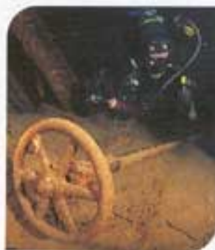
Una llave de paso en la sala de calderas.
